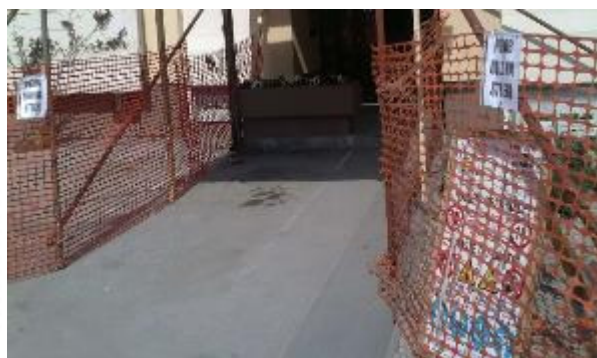
Primer izvedbe zaščitnega nadstreška
