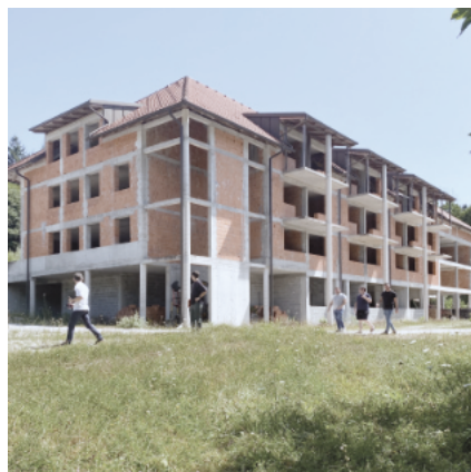
F1: severovzhodna fasada objekta
