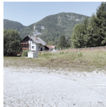
F7: trafo postaja na zahodni strani območja
