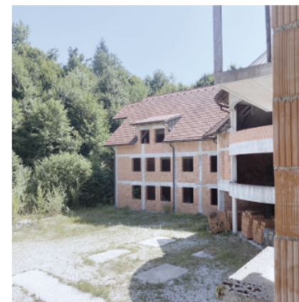
F4: severna fasada daljšega kraka objekta
