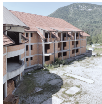
F3: severna fasada daljšega kraka objekta
