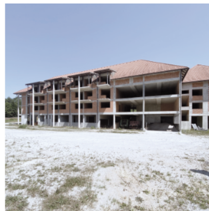
F2: pogled na objekt s ploščadi na jugu
